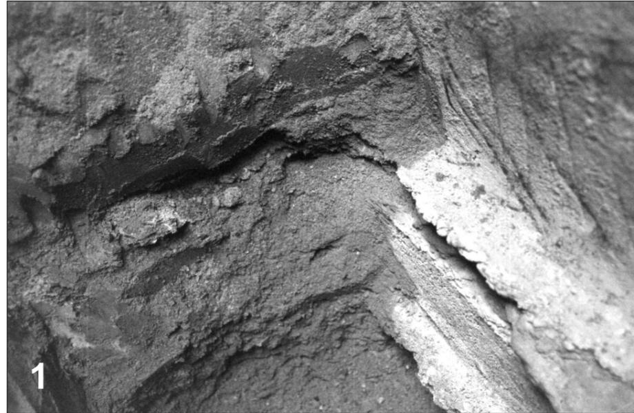
Weil da aber in aller Regel Dränungen als elementarer Baumangel als Ursache für Baumängeln als Wirkungen fehlten, ging ich dem nicht nach, denn dort wäre auch ohne diese Abrissfugen abgesichertes aufgestautes Niederschlagswasser durch hydrostatischen Druck eingeflossen.
