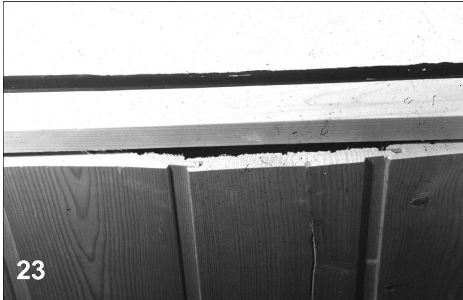
Folgeschwer ist es auch, wenn sich auf Dämmschichten Eisplatten durch gefrierendes Kondenswasser bilden, die als außen falsch liegende Diffusions-Sperrschichten nolens volens wirken. So kommt es, was Bauschäden-Gutachter im Frühjahr erleben.
