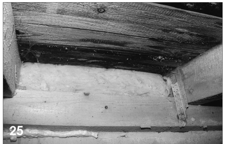
daß die Unterspannbahnen in den Auflageflächen zu Dämmschichten durch Kondensation „schwitzen“ können wie ein Küchensieb über dampfendem Topf.
