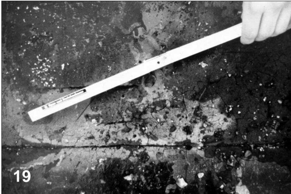
Werden die Dämmplatten so auf die Dichtschicht „geklebt“, und bewegen diese sich unter Kalt-Warm-Wechseln, können sie die Dichtschicht deformieren. Es bilden sich dann Falten und Wellen unter Fugen zwischen Dämmplatten. Nach dem Aufstauchen werden diese auseinandergezogen. So können in der Dichtschicht Bruchlinien durch „Ermüden“ entstehen. Bilder 18, 19
