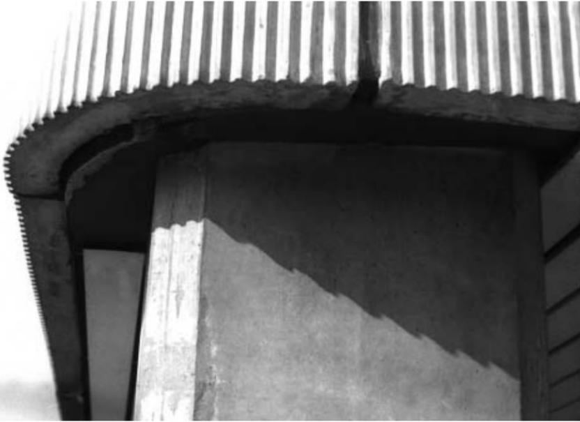
Nicht nur von betontechnischen Ursachen, sondern auch von allzu großer Schlankheit der Stützen, die man durch Betonstahl in Exzessmengen realisiert hat.
